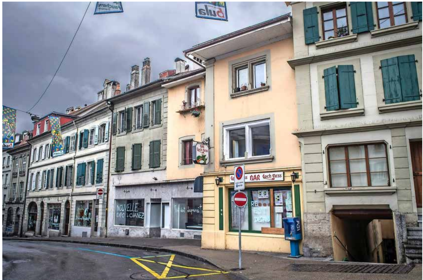
Le prévenu détient deux immeubles situés à la Grand-Rue à Moudon. Le permis d'habiter lui a été retiré en 2005 car les logements sont jugés insalubres et dangereux. Alain Wicht-archives
